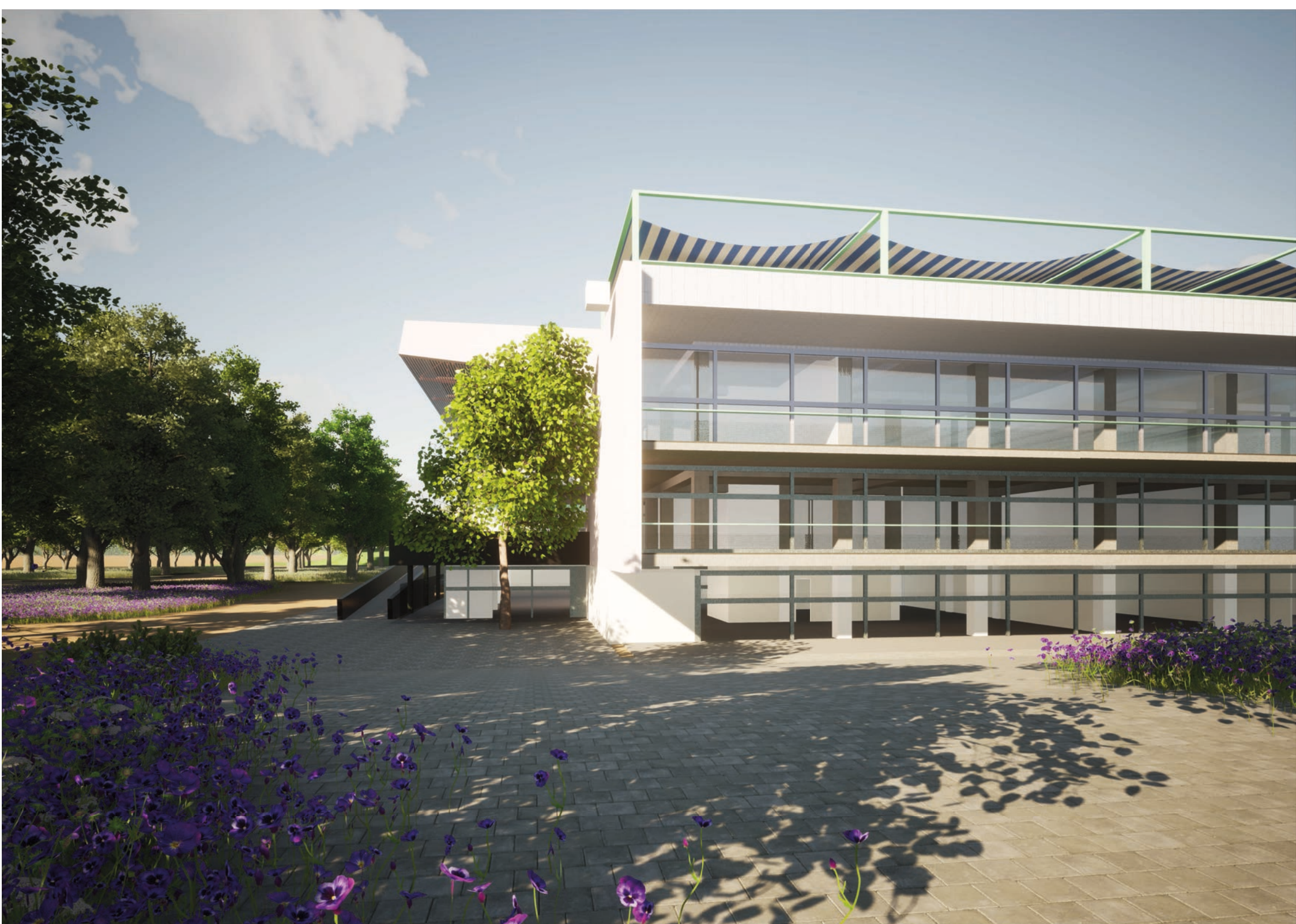
Pohled z prostoru ul. Farského
